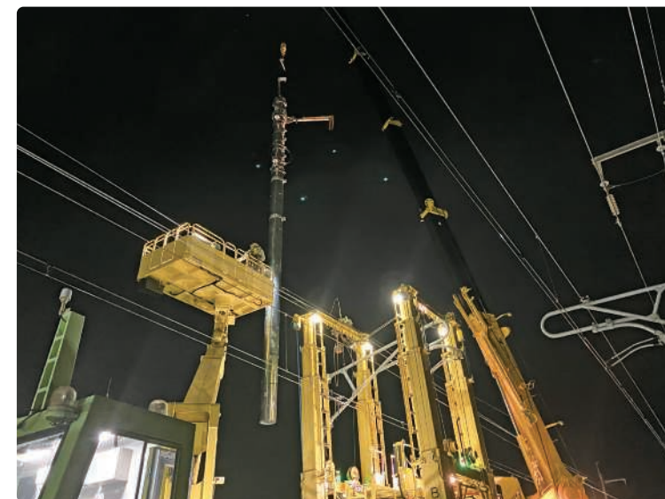
鋼管柱建替工事
